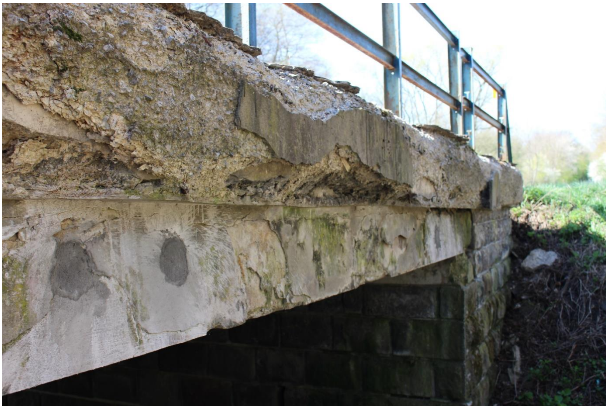
Obr. Degradácia betónu rímky a okrajov nosnej konštrukcie
