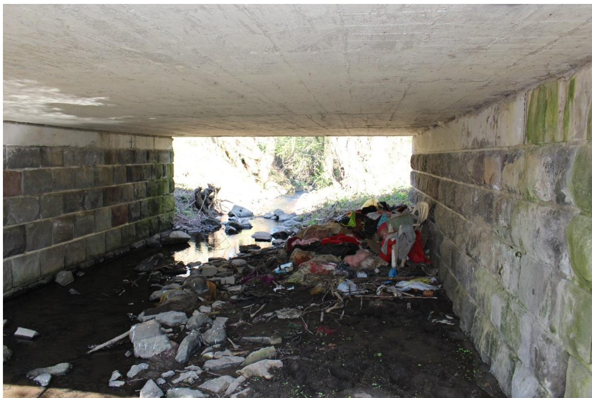
Obr. Pohľad do mostného otvoru - skládka odpadu, nespevnené koryto toku
