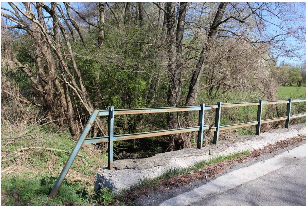
Obr. Nepredpisový stav záchytných bezpečnostných prvkov, degradácia betónu rímky
